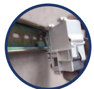
Ejemplo de fijación en carril DIN
