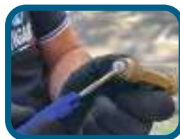
Extracción de junta
