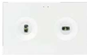
Lente pasillo (cruce techo)
