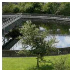
Tratamiento de agua
